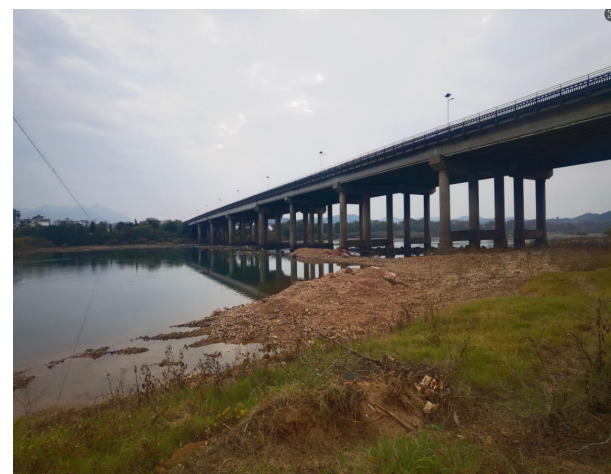
桥梁侧面照片
